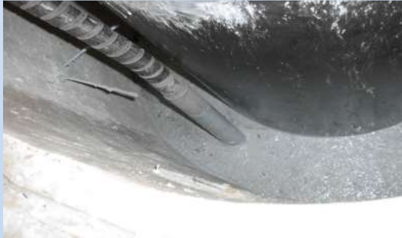
Заливка в опалубку
